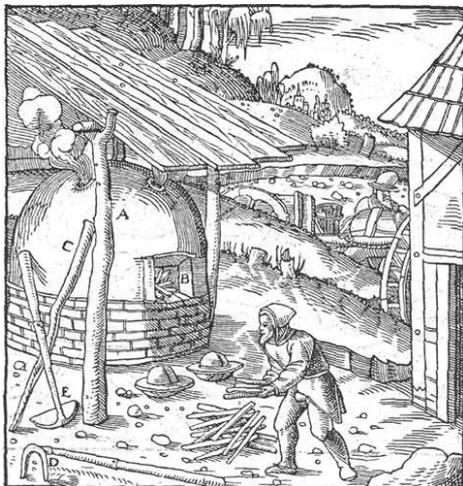
Рис. 6.3. Печь для обжига оловянной руды (Г. Агрикола «12 книг о металлах»)
