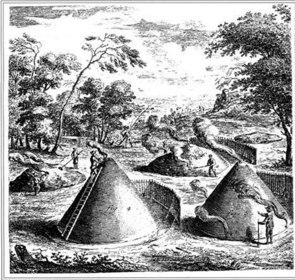
Рис. 7.29. Зажигание, горение и разгребание угольной кучи
