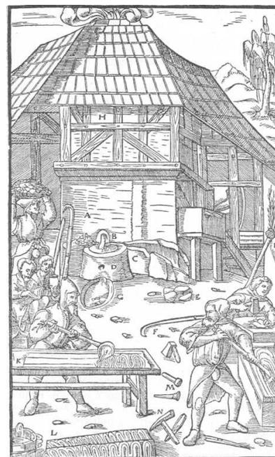
Рис. 6.5. Разливка чистового олова (Г. Агрикола «12 книг о металлах»)
