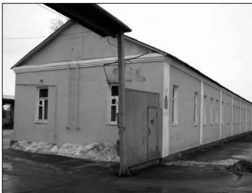
Здание в городе Коломне, улица Полянская, д. 6, где в 1941–1942 гг. формировался 173-й (29-й) отпадн
