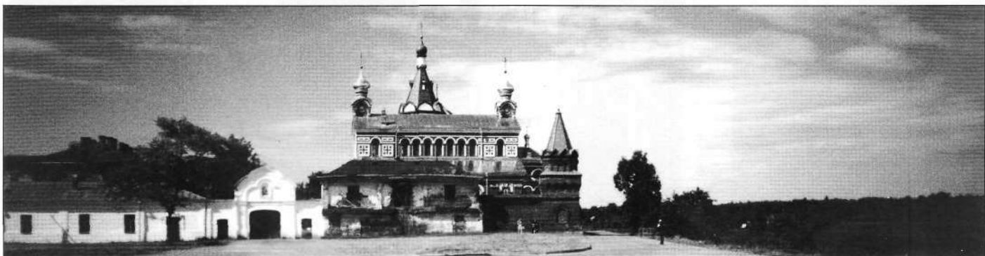
Общий вид Никольского Староладожского мужского монастыря с южной стороны
