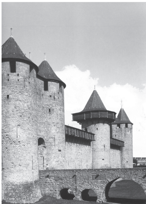
Рис. 16. В'їздова брама м. Каркасон. Фрагментарно відтворені "обланки", змонтовані на консольних балках, друга половина XIII ст.
