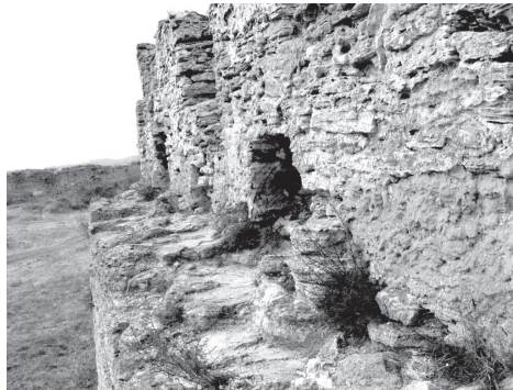
Рис. 10. Той же фрагмент. Вигляд полиці опертя галереї
