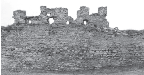
Рис. 7. Фрагмент північного муру зі збереженими мерлонами
