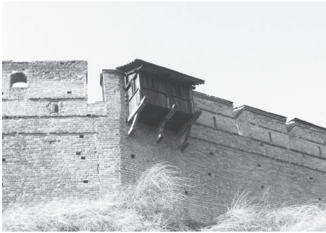
Рис. 13. Дерев'яний «викуш» («комірка драба») на стіні Луцького замку
