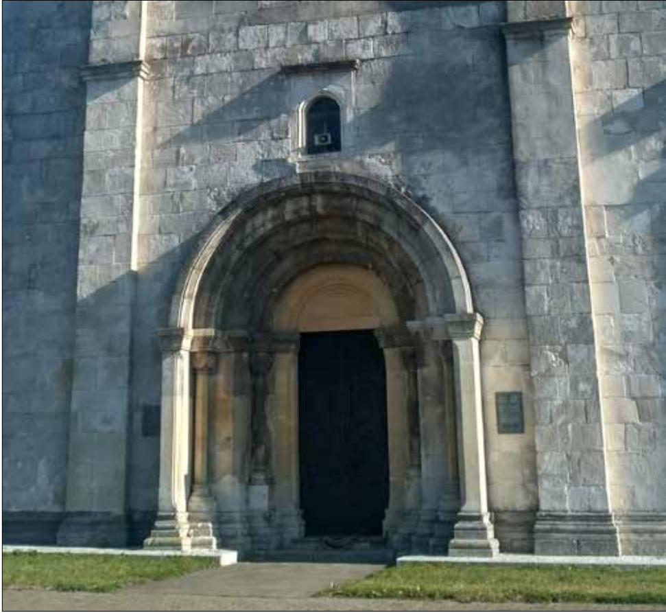
Мал. 5. Західний фасад церкви святого Пантелеймона в Галичі. Фрагмент. Фото автора
