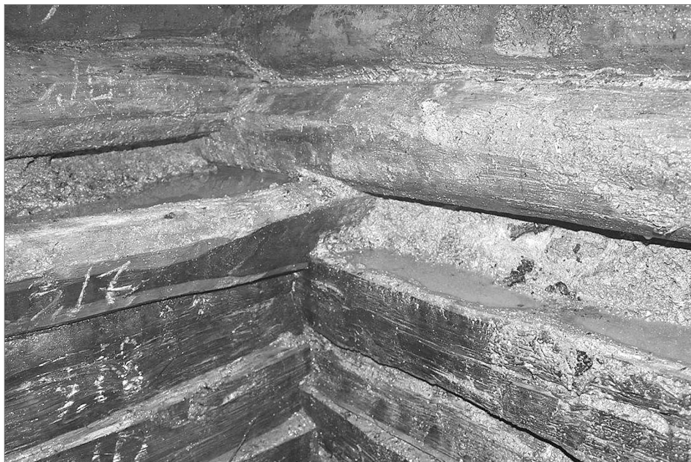
Хорошо сохранившиеся деревянные срубы изготовлены из дубовых бревен и полубревен. Бабина гора. Олевск
